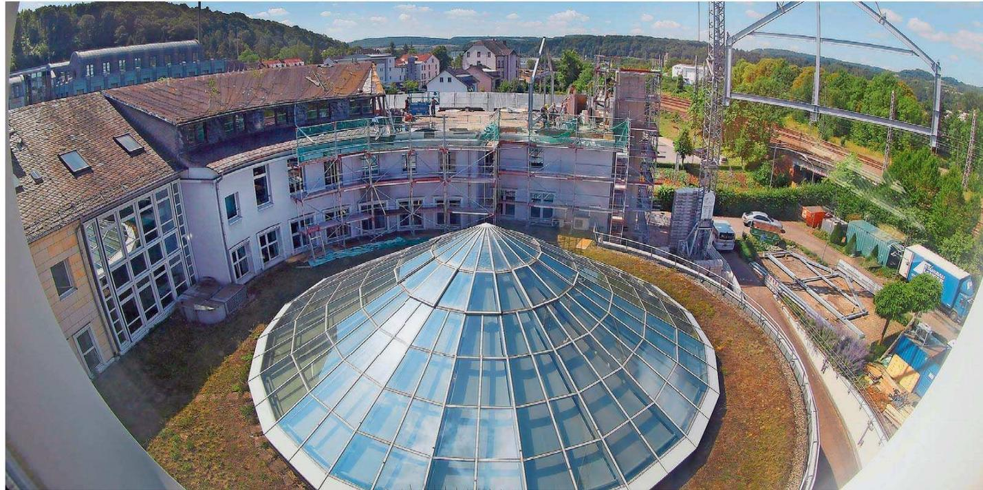
Die Stahlrahmen für die Dachkonstruktion werden mit dem Kran auf das oberste Geschoss des Altbau gehievt. Im Vordergrund ist die Glaskuppel des ImmobilienCenters zu sehen. FOTOS: SPARKASSE/M. MÜLLER
