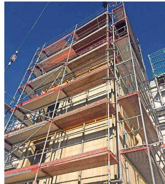
Herzstück der Sanierung: der neue Aufzugschacht am Gebäudegiebel Richtung Kaufland-Kreisel.
