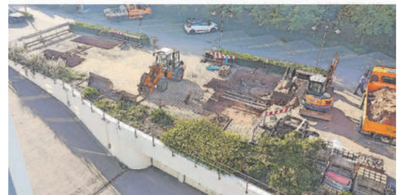
Insbesondere die Tiefbauarbeiten an den Fundamenten der neuen Carports waren nach den Worten von Frank Jakobs, Vorstandsvorsitzender der Sparkasse, „sehr herausfordernd“.
